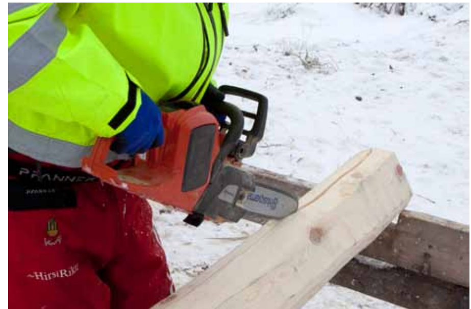
Alussa tarvitaan työkaluja. Akkusaha on osoittautunut kätevä peliksi tarkkaan työstöön.
