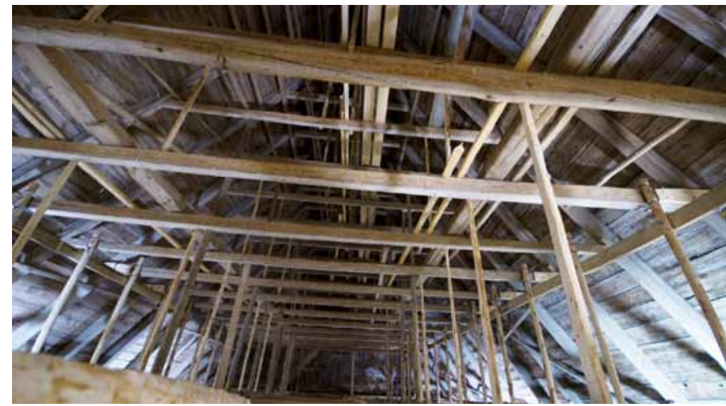
Hattulan kirkon sakastin kattorakenne on konttikattotuolitekniikkaa edeltävää varhaiskeskiaikaista mallia.)
