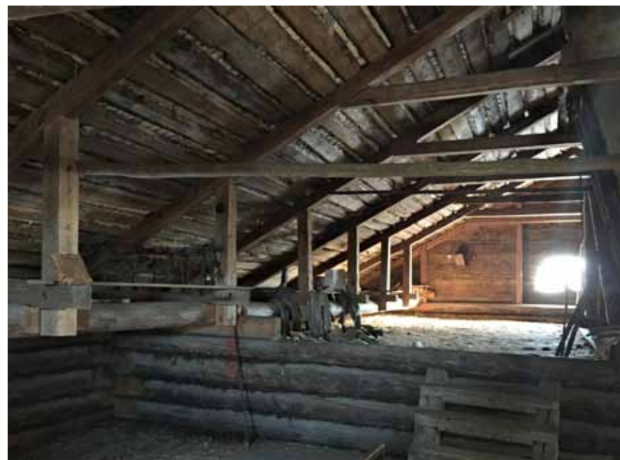
Konttikattotuoleja alettiin keskiajalta lähtien käyttää myös hirrestä salvoutuissa rakennuksissa; ensin kirkoissa ja 1700-luvulta lähtien myös talonpoikaisessa rakentamisessa.
